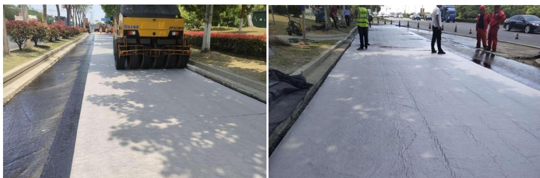
图 9 南京市宏运大道项目
