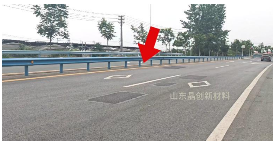
图 7 同步碎石封层路段
