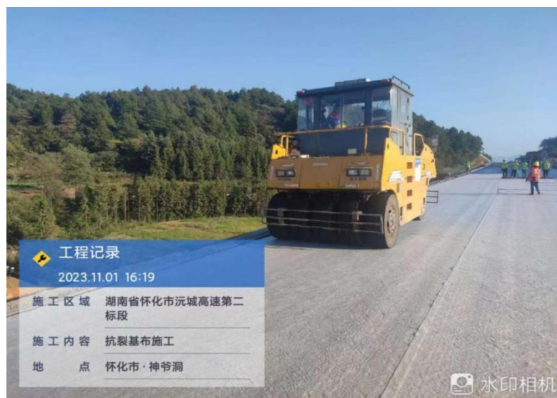
图 1 沅辰高速防裂基布施工
