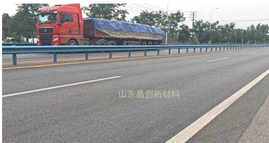
图 6 铺设防裂基布路段
