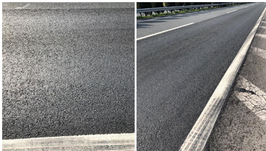
图 4 铺设聚丙烯长丝防裂基布路段
