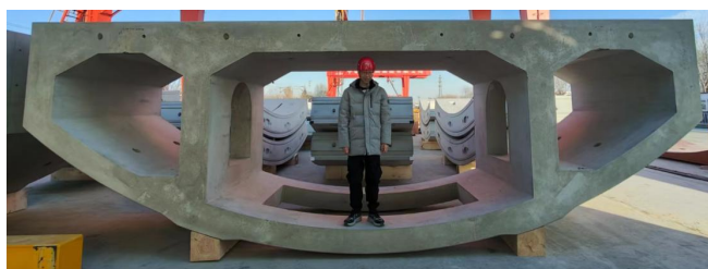
说明图 2 某铁路盾构隧道轨下空间
